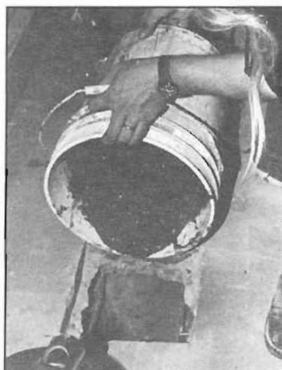
Pourin' the cement.
